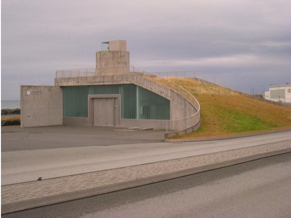
Nýleg dælustöð við Norðurgarð
